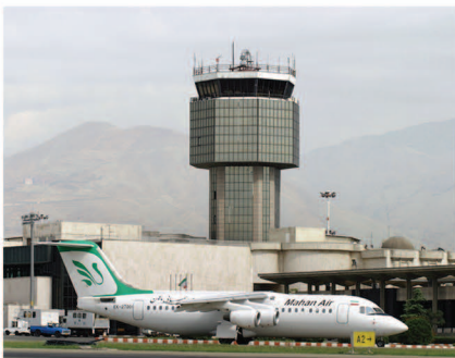
برج مراقبت فرودگاه مهرآباد
